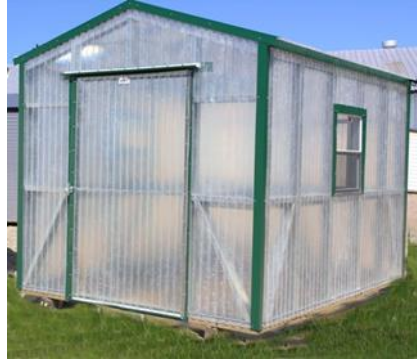
Şekil 1.6. Fiberglas örtülü sera
